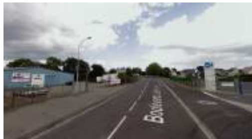
Le traitement des espaces publics et des abords des constructions : un enjeu de requalification et d'attractivité des zones d'activités d'entrée de ville
