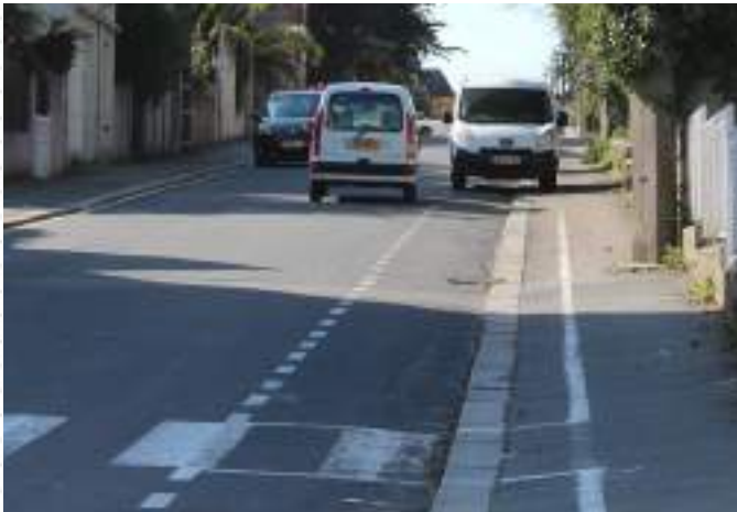
Marquage au sol à la fois sur la chaussée et le trottoir Empiètement sur l'espace réservé au piéton
