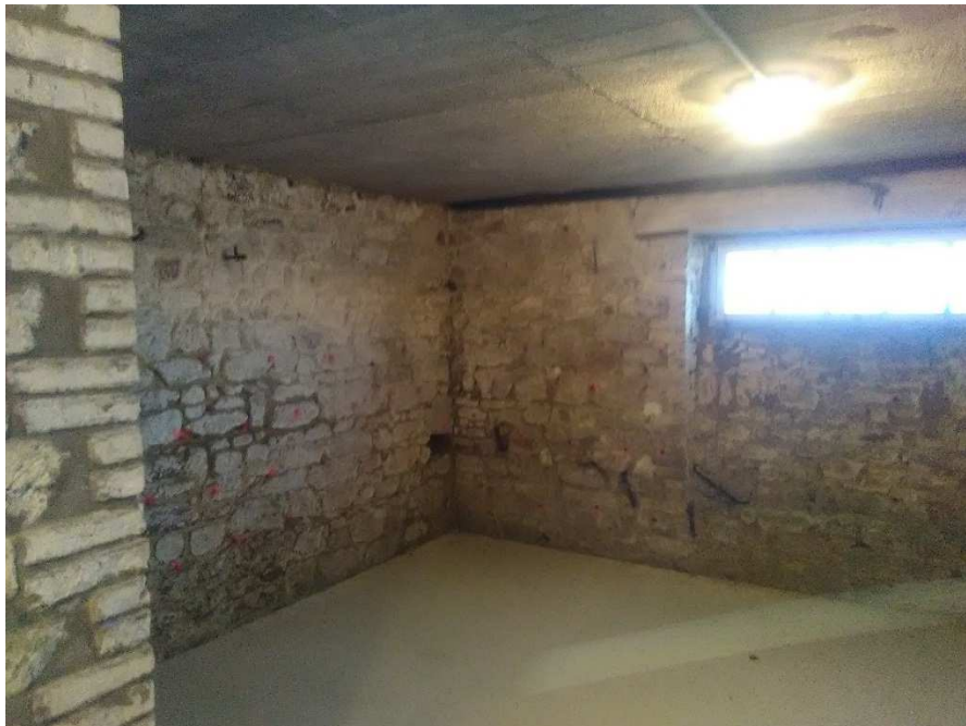
Local sous-sol sous future cuisine
