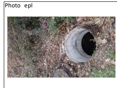
Regard eaux pluviales
