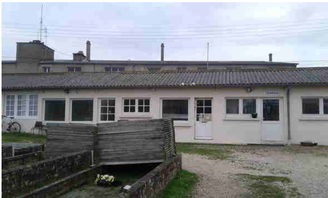
Extérieur (Bureaux) - Toiture - Plaques ondulées fibre ciment
