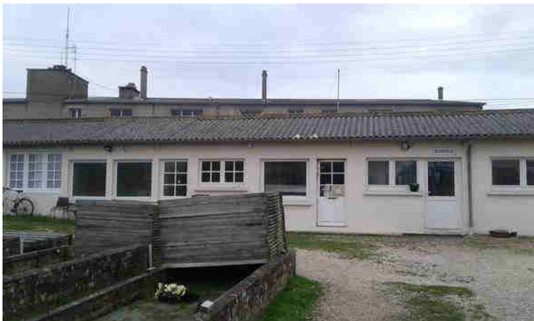
Extérieur (Bureaux) - Toiture - Plaques ondulées fibre ciment
