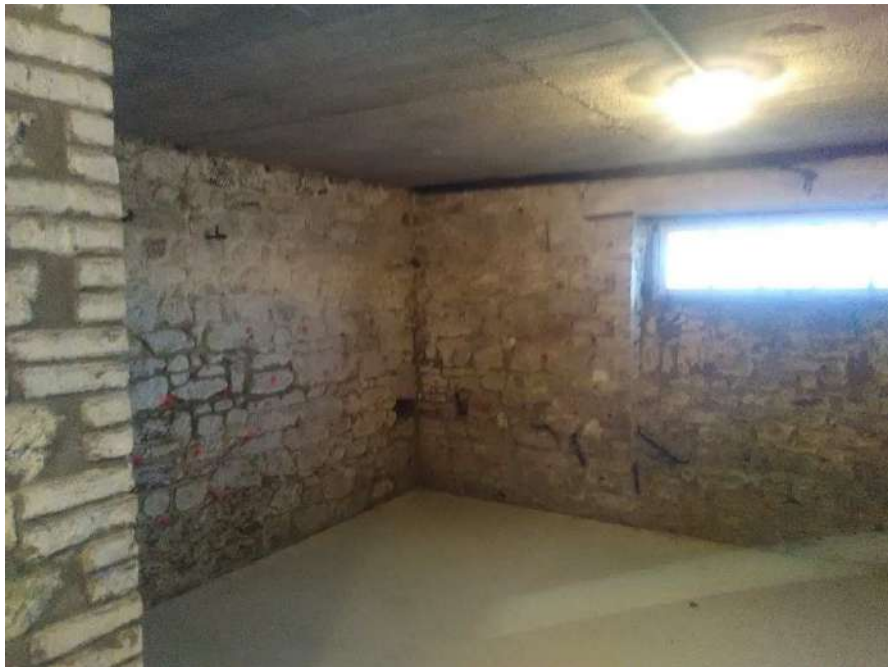
Local sous-sol sous future cuisine
