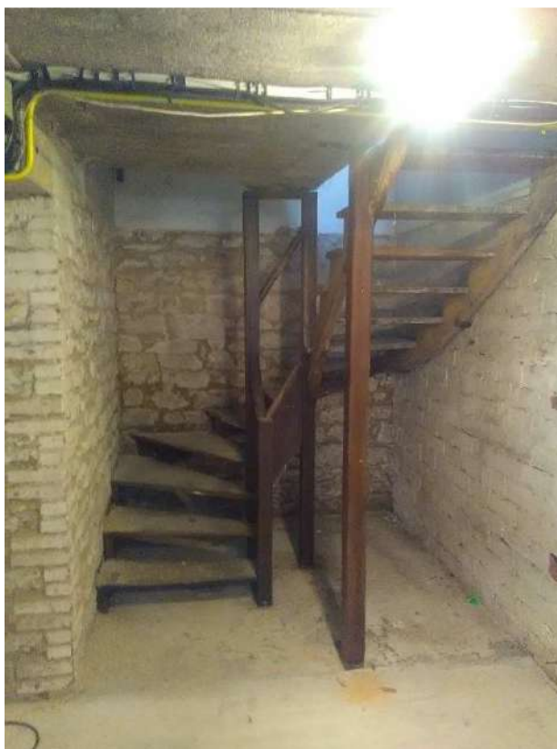
Escalier d'accès au sous-sol
