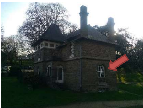
Vue d'ensemble de la bâtisse – localisation du local concerné.
