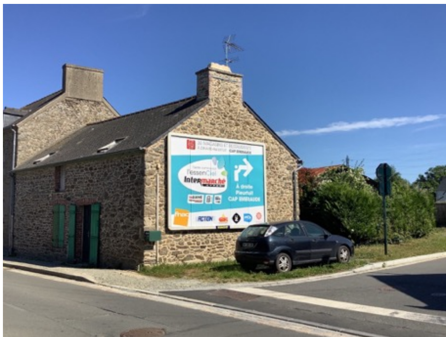
Préenseigne sur mur aveugle de plus de 12 m 2 et dépassant les limites de l'égoût du toit, Dinard, juin 2021
