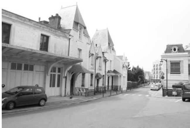
Avenue Georges V: Seule la façade sur rue a été protégée.
