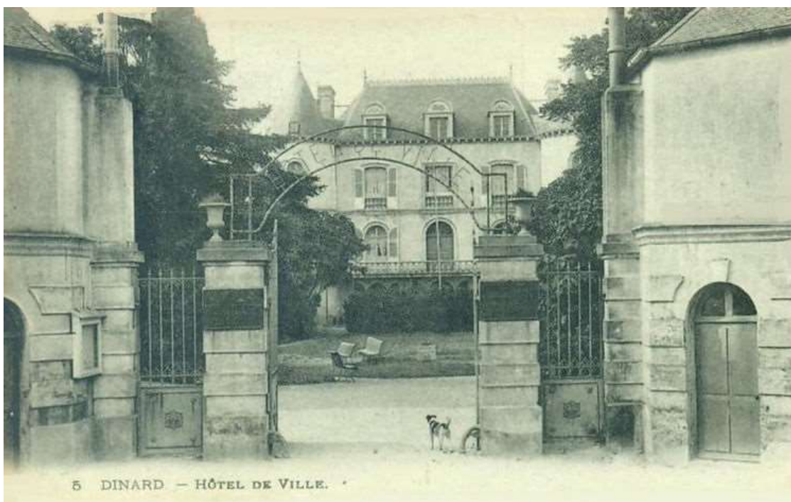
Figure 2 - Pavillons et portail d'entrée supprimés qui peuvent être reconstruits à l'identique
